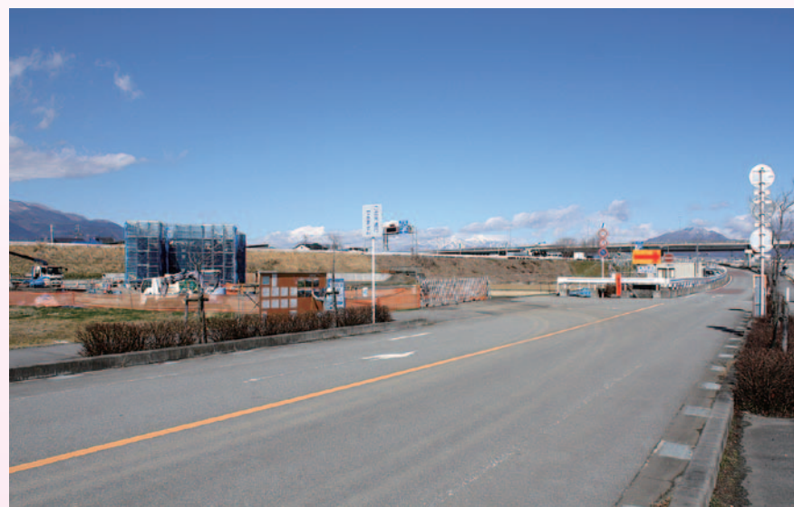
田富西通り線(環状道田富西ランプから市役所への道路)整備 平成30年度完成予定
